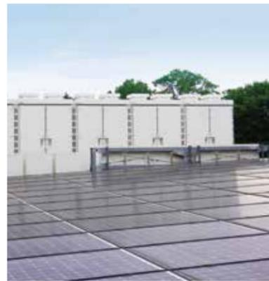
屋上の太陽光パネルで発電した電力は、6つある「蓄電池」に蓄えています。災害や停電時のために蓄えている電力ですが、通常時も夜間照明や館内電力のために使われています。さらに、移動式蓄電池に充電し、キッチンカーで使用する電力としても活用しています！
