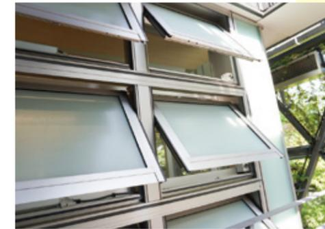
戸越公園に繋がる1F広場口から3Fの大きな階段。この階段のどこかに12枚の自然換気窓があります。過ごしやすい春や秋には空調をなるべく使わず、外の空気と建物の中の空気を入れ替えることで室内の温度を調整しています。自然の空気の流れを動力にしているので、自動で開閉していても、電力は使っていません。ゆっくりパタパタしていたり、風のある日は忙しくパタパタしていたり…換気窓の動きぶりをぜひチェックしてみてください。
